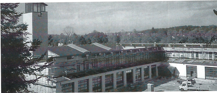
Feuerwehrwache Füssen im Bau.
