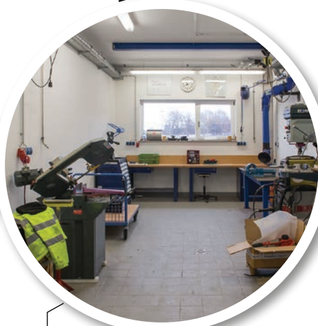
Werkstatt direkt neben der Waschhalle
