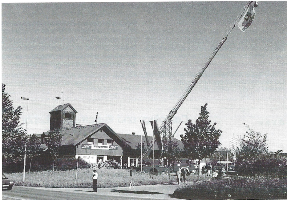
Feuerwehrhaus - Im Vordergrund die Rettungsleiter.
