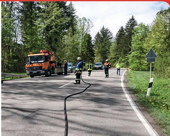
Vermessungsfirma wurde festgestellt, dass die Gasleitung bereits beim Bau der Plankenanlage im Herbst 2018 auf einer Länge von weiteren 133 Meter mindestens an 8 weiteren Stellen getroffen wurde. Auf Grund der Gefahr wurde vom Gasversorger ein sofortiger Bypass bzw. Austausch der Leitungen angeordnet. Die Ursache lag wohl bei diesem Einsatz darin, dass die Erdgasleitung nur eine Deckung von ca. 80 cm (anstatt 1,20m) aufwies und diese daher beim Bau der Beplankung mehrere male getroffen wurde.
