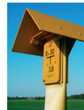
Diese Schilder weisen auf eine Erdgasleitung hin, die unterirdisch verlegt wurde.
